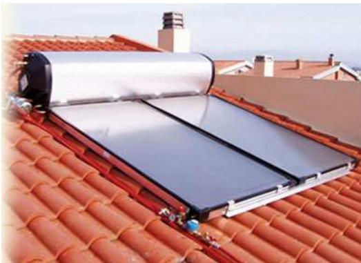
Un impianto solare termico è generalmente costituito dal **pannello e dal serbatoio di accumulo dell'acqua**; la circolazione del fluido termoconvettore tra il pannello e il serbatoio può avvenire naturalmente o forzatamente per mezzo di una pompa elettrica. In entrambi i casi gli impianti producono acqua calda che può essere utilizzata direttamente o che può essere inviata ad una caldaia.
